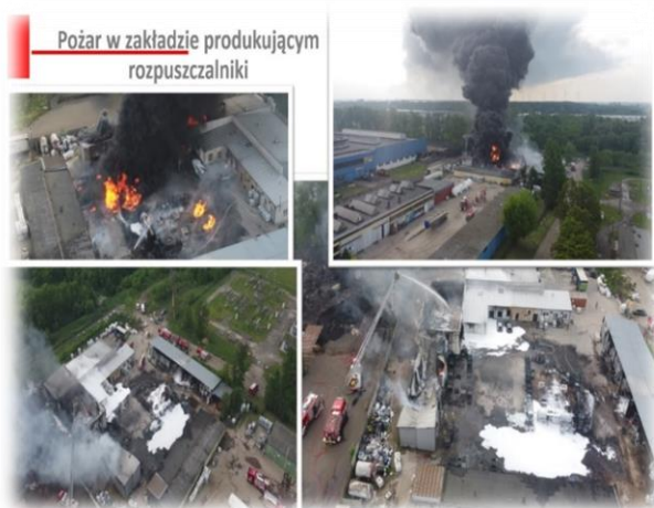
Zdjęcie IV.2. Pożar zakładu
